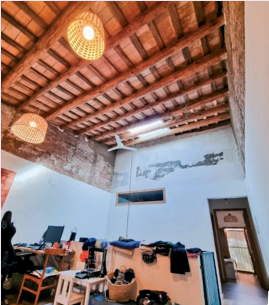
La segona planta, amb les parets de tàpia i els sostres de fusta visibilitzats
